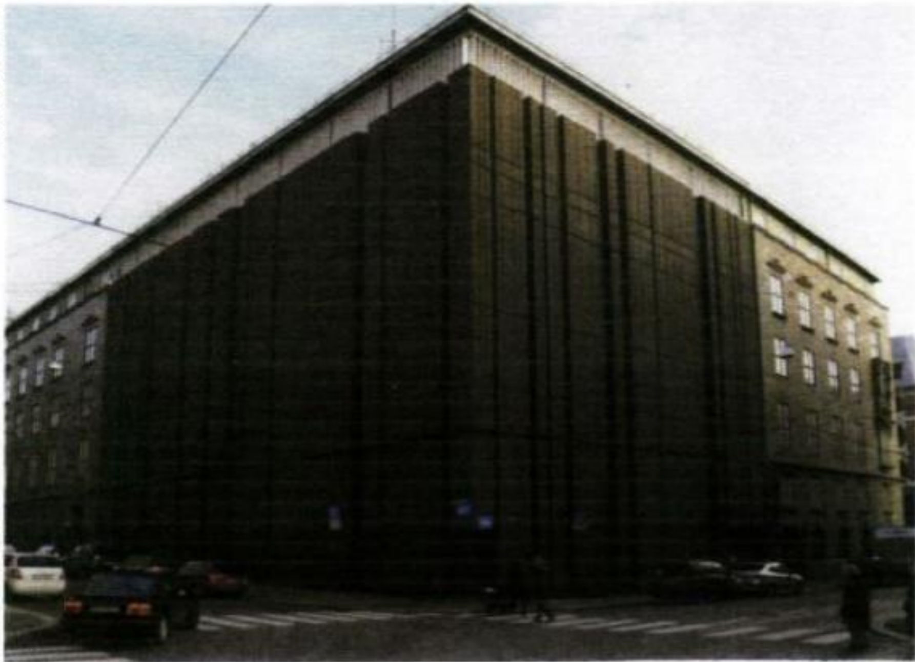
Telegrafbygningens nyere del flankert av opp- rinnelig byggverk.
