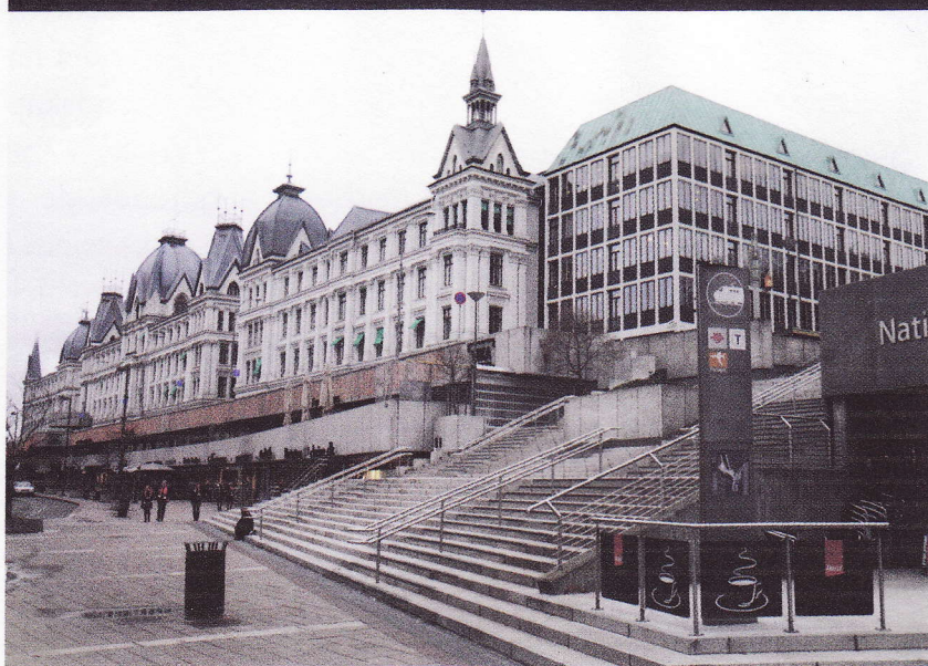
2012: Den ferdige trappen og nytt inngangsparti til Nationaltheatret stasjon.
